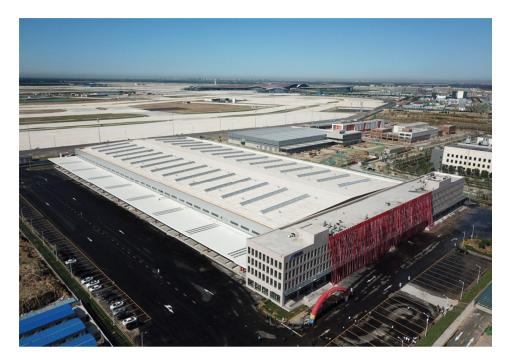
北京大兴国际机场南航基地国内货运项目由建筑安装分公司承建。作为南航 北京枢纽建设的重要组成部分,项目从 2018 年 5 月进场,到 2019 年 5 月竣工, 仅历时一年,就完成了 5. 59 万平方米的工程建设。项目结构形式为钢结构,其 中货运站为单层框排架结构,总跨度 120 米,在施工过程中采用工厂加工预制、 现场拼装、吊装的工序,保证了大跨度空间钢结构的施工品质。
